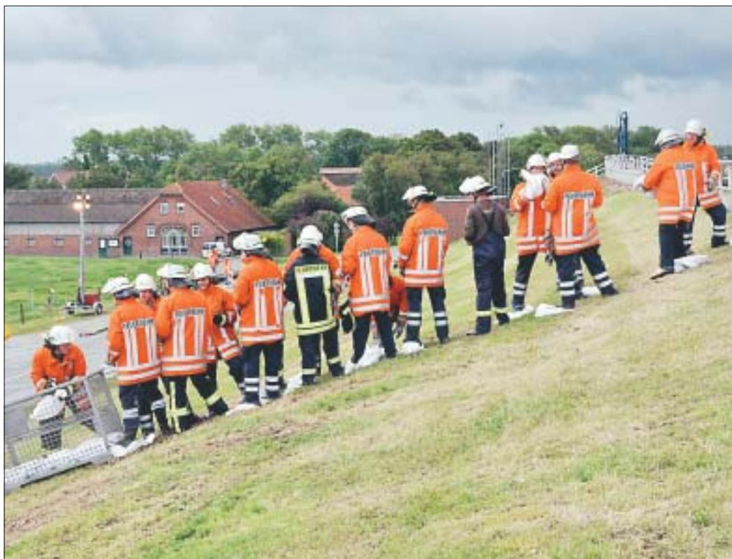
Die Feuerwehr bildete Menschenketten, um Sandsäcke von der Ablagestelle zur Deichkappe zu bringen. BILD: JAN LEHMANN
