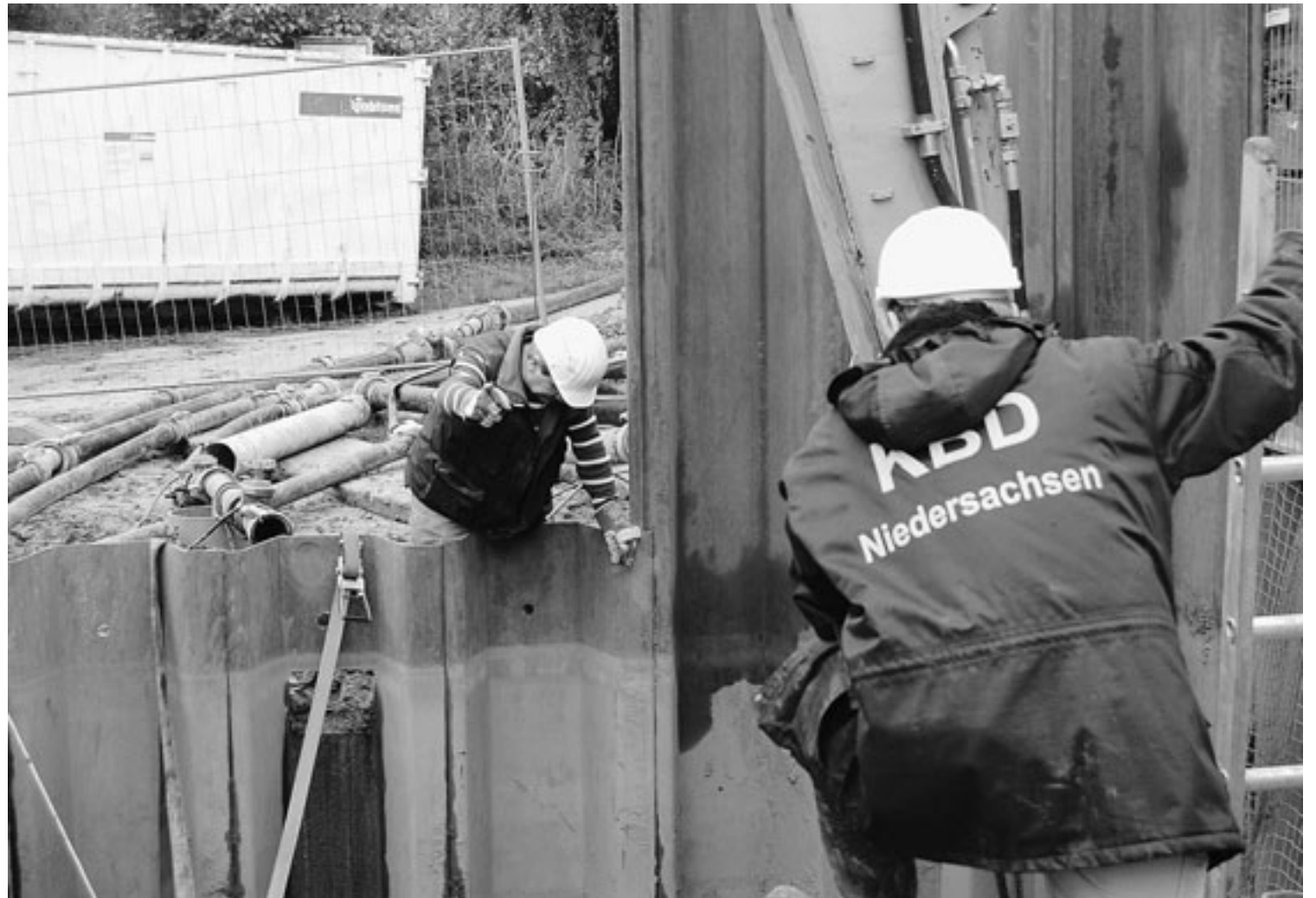
Mitarbeiter des Kampfmittelbeseitigungsdienstes setzten gestern Vormittag noch einen so genannten Pumpensumpf, damit die Bombe auch vom letzten Grundwasser befreit wurde. Am Nachmittag war alles soweit vorbereitet, dass der Blindgänger entschärft werden konnte. FOTO: WENKE
