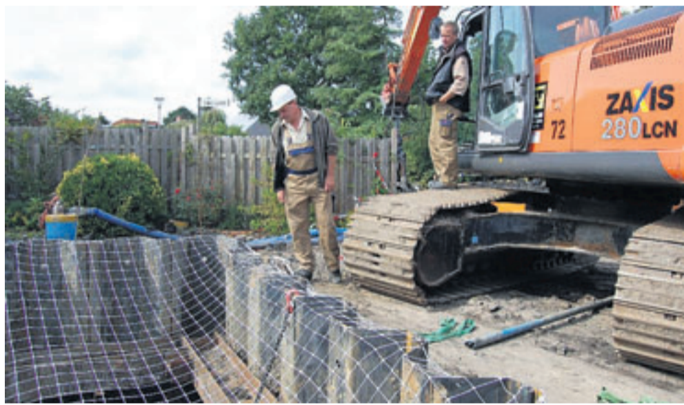
Sprengmeister Thomas Gesk vom Kampfmittelräumdienst überprüft die Tiefe. Nach fünf Metern war Schluss, erst nach Evakuierung wurde das letzte Erdreich bis zum Blindgänger entfernt. MES
