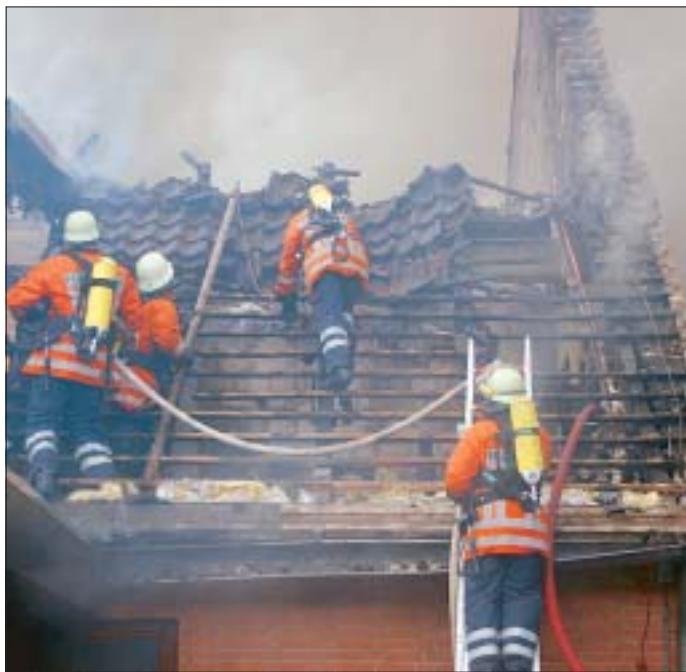
Eine schwere und gefährliche Aufgabe: Unter Atemschutz kletterten die Feuerwehrleute der Brandruine aufs Dach.
